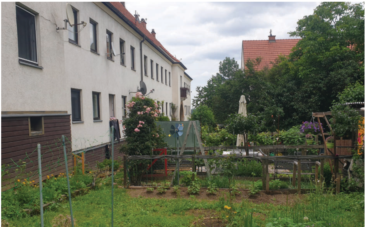
Dreiersiedlung, Ternitz. © Autor:innen
